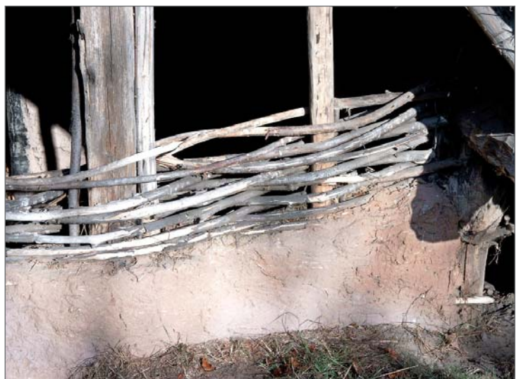
Abb. 2: Teilweise mit Lehm verstrichene Flechtwerkwand.
