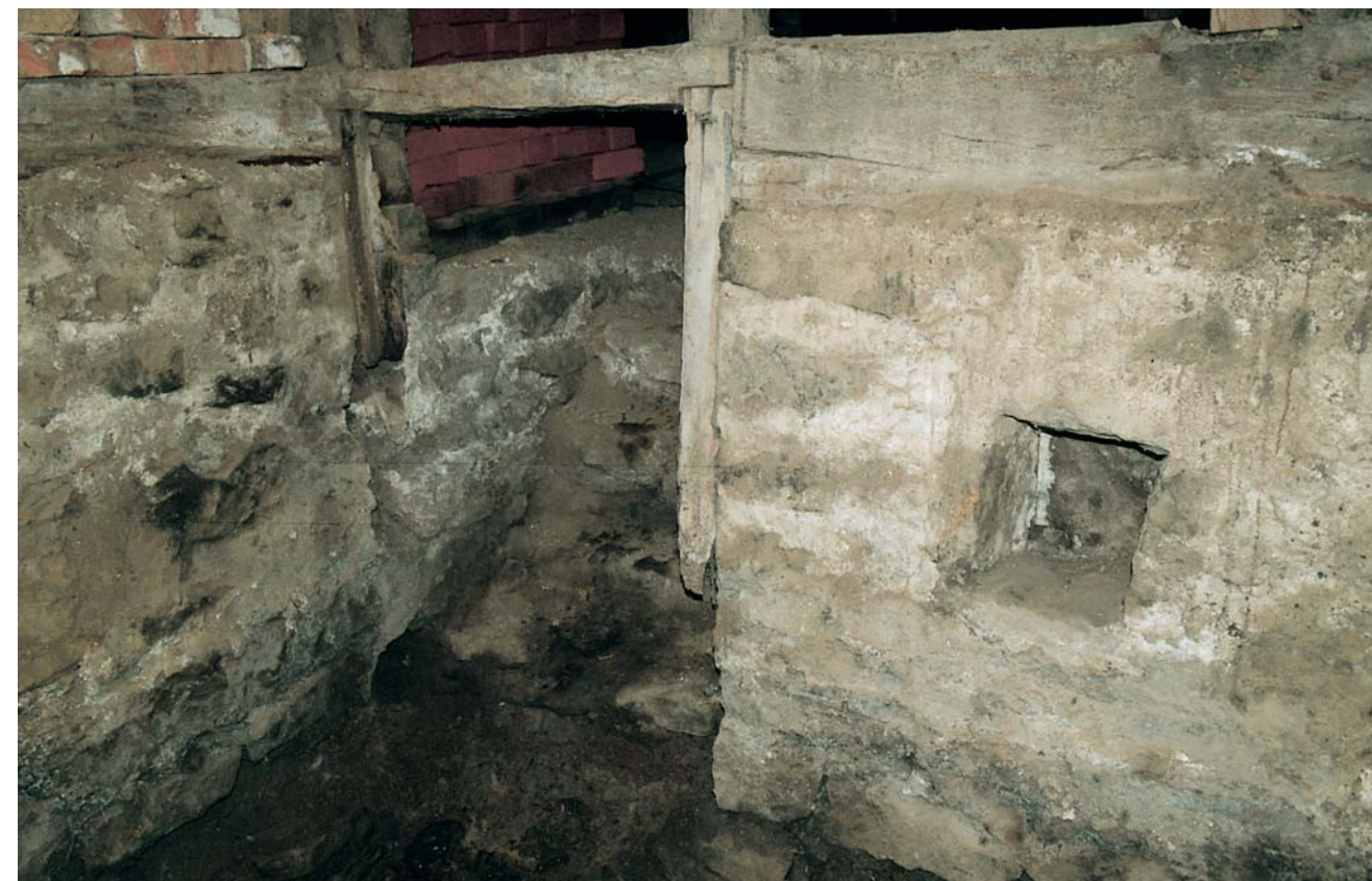
Abb. 5: Kalletal-Lüdenhausen. Neben der Kellertür befand sich oberhalb des Tauchbeckens eine Nische, in der ein Licht abgestellt werden konnte.
